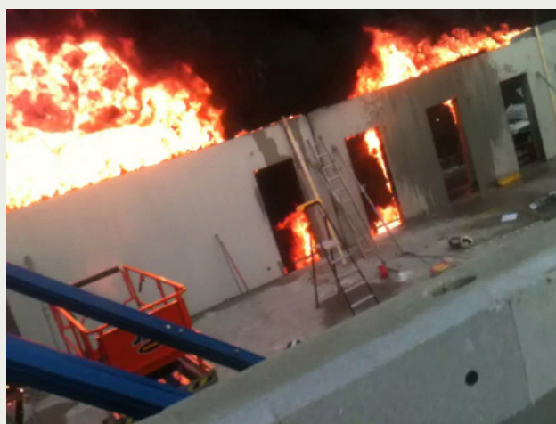
Bild 1. Brandtillbud i grafit-EPS i halvsandwichvägg under produktion. Branden är inte möjlig att släcka med den utrustning som finns på platsen, och brandröken kan försvåra släckning och utrymning. Foto: Skanska
